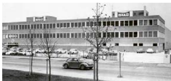
BÄKO-Gebäude in Taufkirchen
