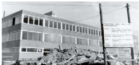
Baustelle der ELBIM in Taufkirchen
