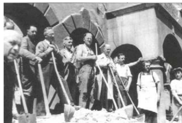
Schuttarbeiten in der Maistraße 12, 1948
