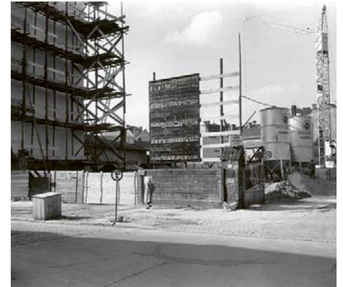
Baustelle Neubau Maistraße 14 am 12. Oktober 1956
