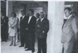
Sichtlich zufrieden mit dem Stand der Dinge im fertiggestellten Rohbau zeigten sich Auftraggeber, Bauausführende und ein illustrierter Kreis von Ehrengästen, die sich zum zünftigen Richtfest bei Deutschlands größter BÄKO-Genossenschaft eingefunden hatten und den baulichen Zuwachs als richtige Antwort auf die Anforderungen der Zeit begrüßten.
